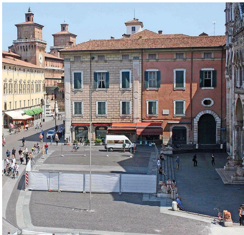
■ La recinzione montata davanti al duomo per il nuovo cantiere
