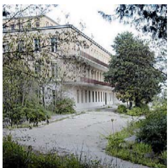
L'EX OSPEDALE L'area dei lavori
